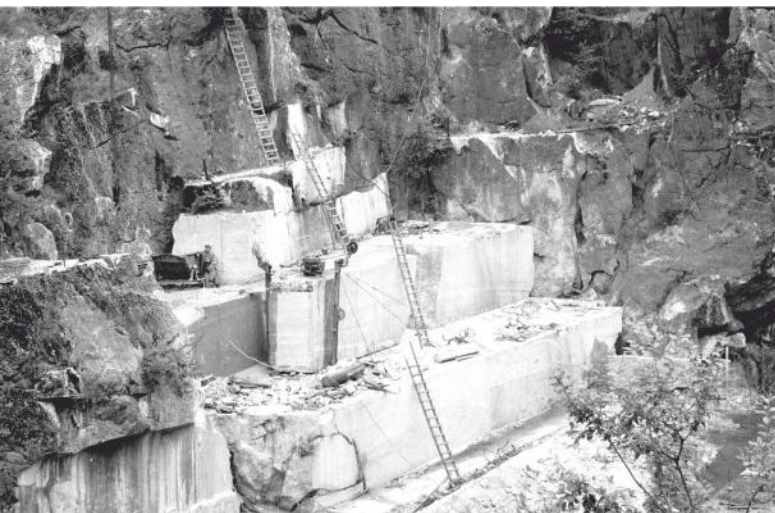
Der Steinbruch „Bongard“ zwischen Runkel und Villmar Anfang der 1960er Jahre
